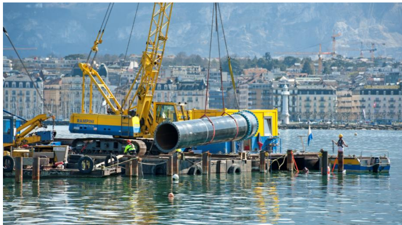
Immersion du tronçon
