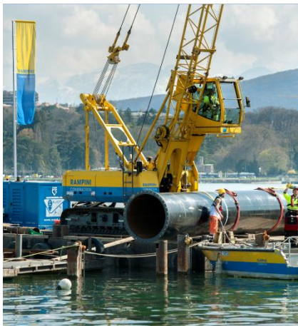
Manutention du tronçon
